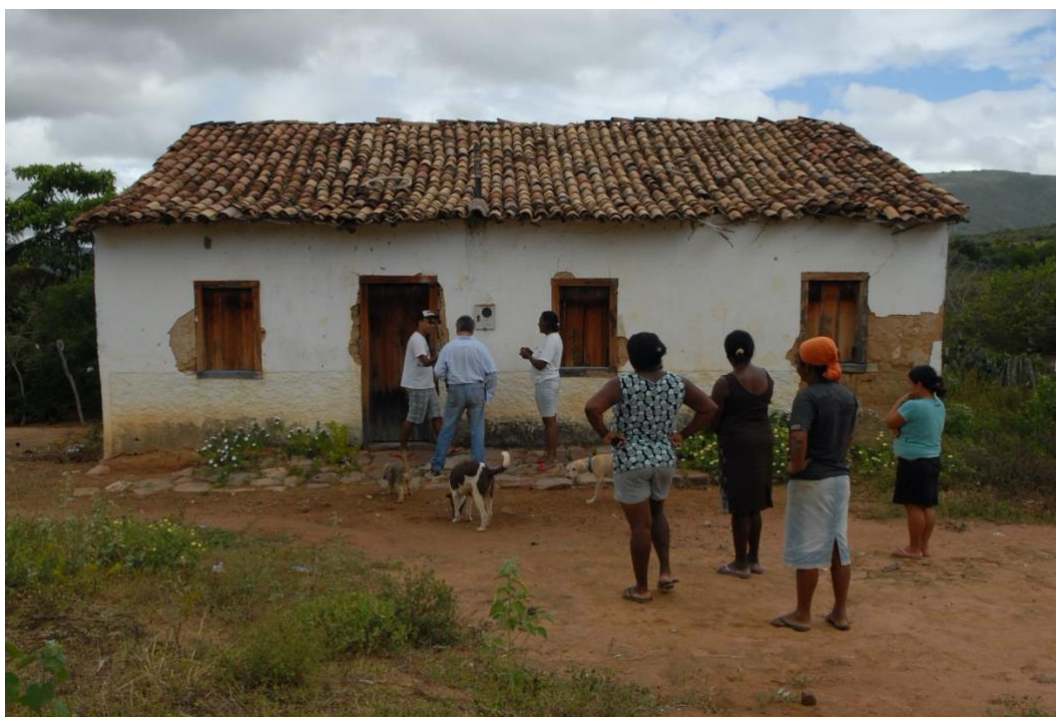
Figura 2: Tucum. Exemplo de casas de arquitetura vernacular, da região de Tanhaçu.
